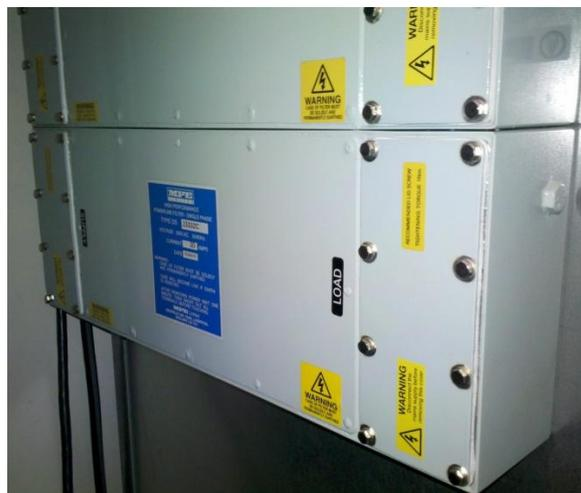
**Figura 4.57: Filtros EMI alimentación cámara anecoica**
